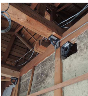
耐震リング取付
